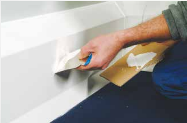
Le protezioni in SaniCoat e in Natural possono essere facilmente riparate da eventuali danni subiti.
